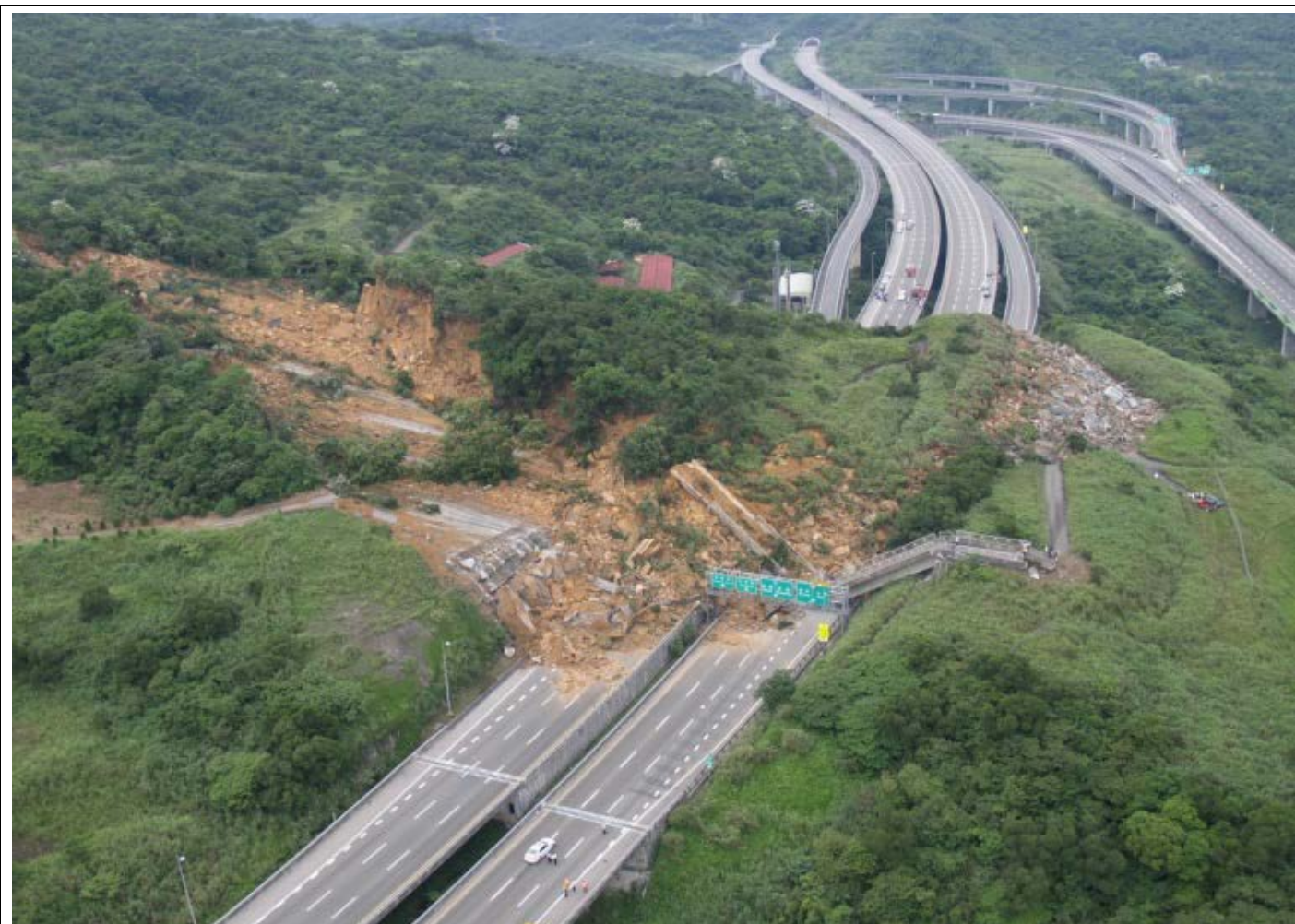
圖 2 國道 3 號 3K+100 邊坡崩塌
