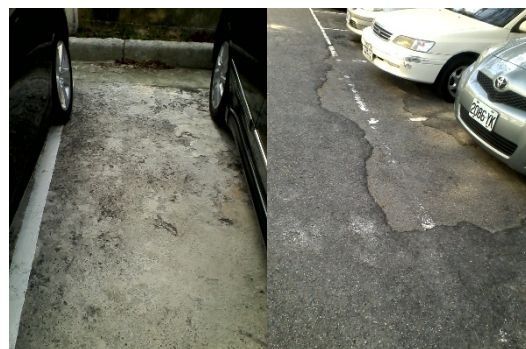
照片 6 新工學大樓前汽車停車區鋪面損壞狀況
