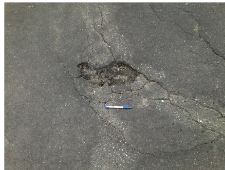
照片 5 新工學大樓前車道鋪面損壞狀況
