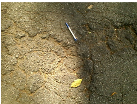
照片 5 新工學大樓前車道鋪面損壞狀況 (續)
