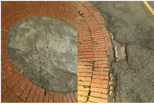
照片 4 新工學大樓前人行道鋪面損壞狀況 (續)
