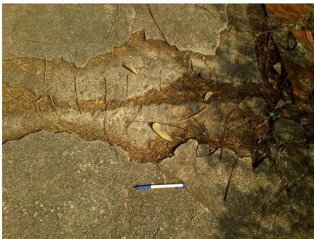
照片 4 新工學大樓前人行道鋪面損壞狀況 (續)
