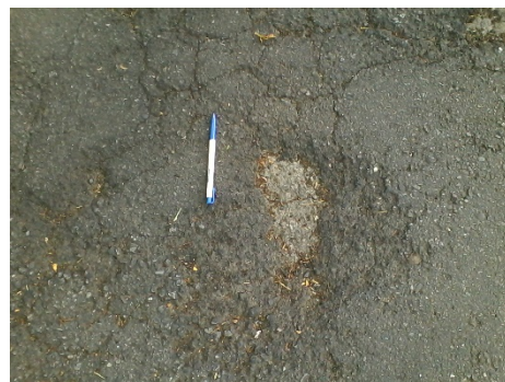
照片 5 新工學大樓前車道鋪面損壞狀況 (續)
