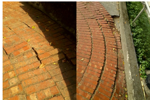
照片 4 新工學大樓前人行道鋪面損壞狀況
