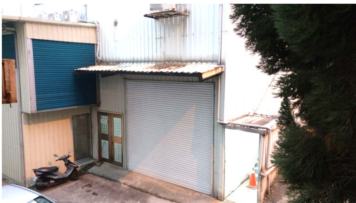
淡江大學風工程中心一號風洞實驗館(小風洞)
