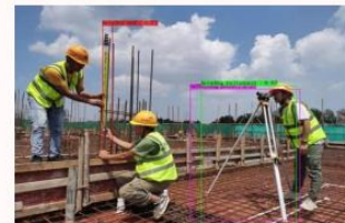
圖2 水準儀被重複偵測為是水準尺及反射鏡,推測是因為反射鏡也需要用角架固定,外觀也跟水準尺相近
