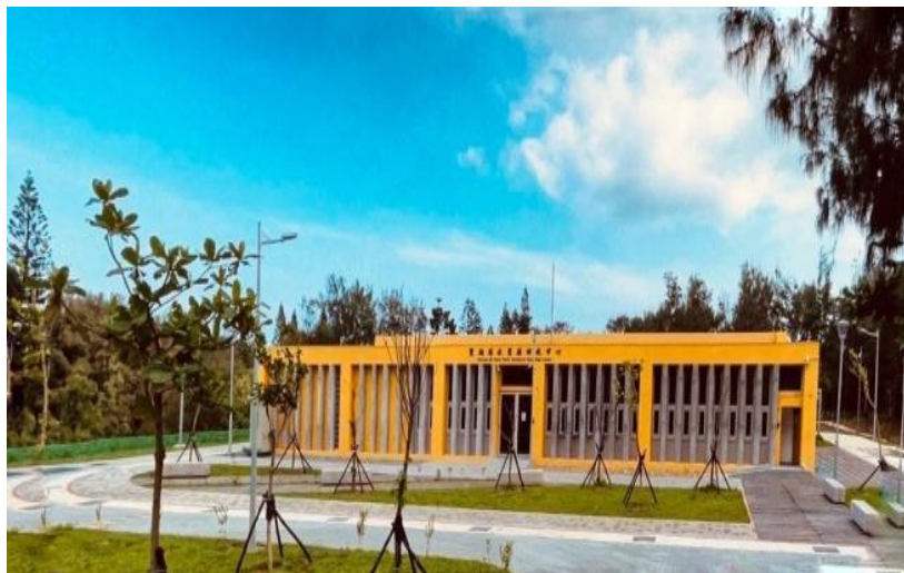
第 21 屆金質獎澎湖縣馬公地區污水下水道系統第一期工程-雙湖園水資源回收中心新建工程
