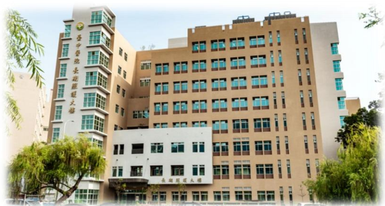
第 18 屆金質獎優等-衛生福利部臺中醫院長期照護大樓擴建計畫新建工程
